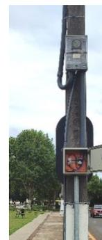
Fig. 2 - Padrão monofásico com quadro de distribuição
