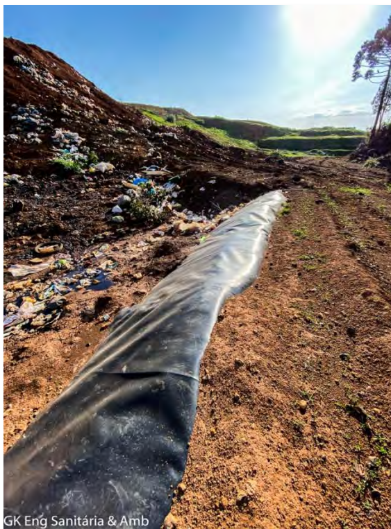
Figura 23 - Base da porção do maciço de resíduos sólidos já encerrada, com destaque para a geomembrana de PEAD de 1,5 mm de espessura utilizada para impermeabilização de base. Fonte: GK ENGENHARIA, levantamento de campo.
