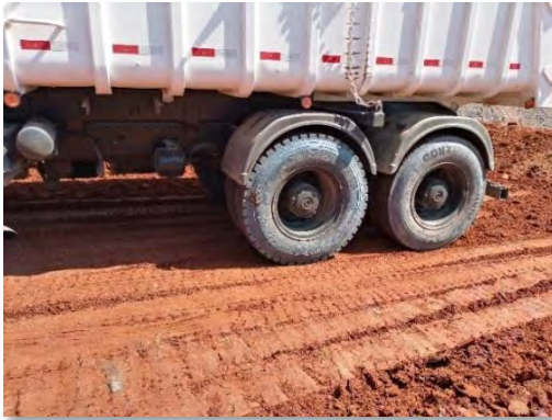
Foto 3 - A selagem e o acabamento final do topo da camada C1 serão realizados com compactação pneumática, a partir de múltiplas passadas de motoniveladora e caminhões basculantes carregados.
