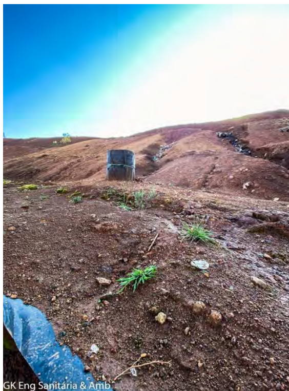
Figura 33 - Vista geral de um dreno de gases instalado na base da célula 1. Fonte: GK ENGENHARIA, levantamento de campo.
