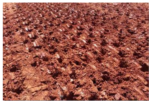
Foto 2 - Material argiloso da camada C1 compactado.
