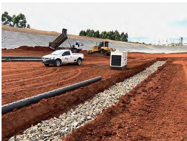
Foto 11 - Abertura e preenchimento da base da vala de drenagem de chorume com pedra rachão.
