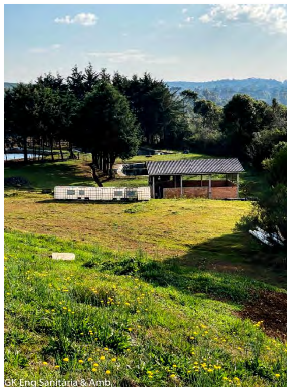
Figura 42 - Casa de química da ETE. Fonte: GK ENGENHARIA, levantamento de campo.
