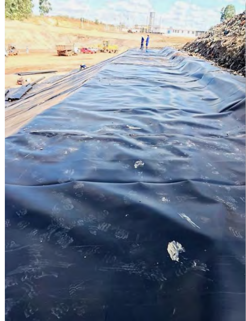
Foto 9 - Exemplo de como deverá ser realizada a ancoragem da geomembrana entre cada etapa de ocupação da célula.
