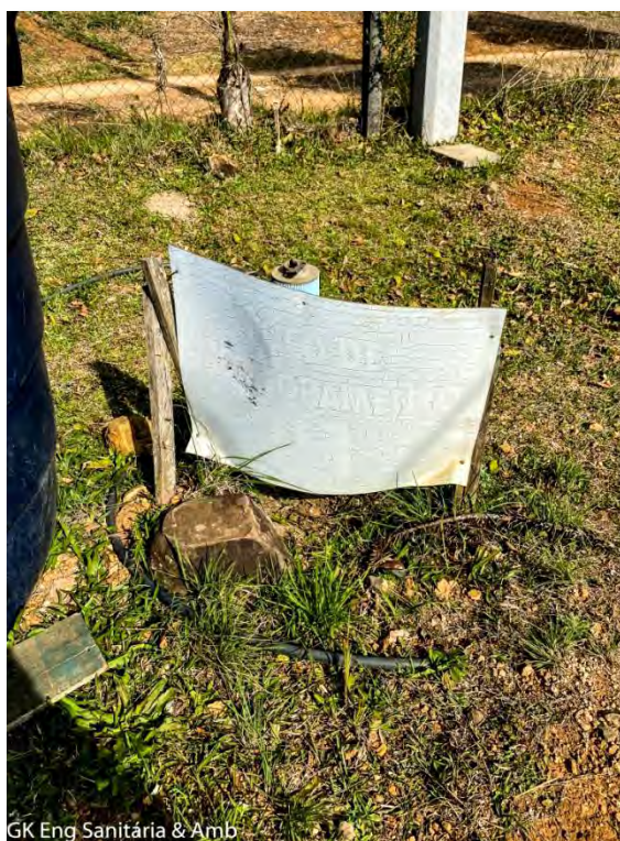
Figura 59 - Poço de monitoramento 01 situado mais a montante - oeste na área de interesse (ponto branco). Fonte: GK ENGENHARIA, levantamento de campo.
