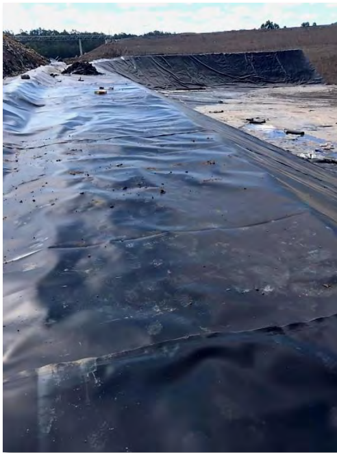
Foto 9 - Exemplo de como deverá ser realizada a ancoragem da geomembrana entre cada etapa de ocupação da célula.
