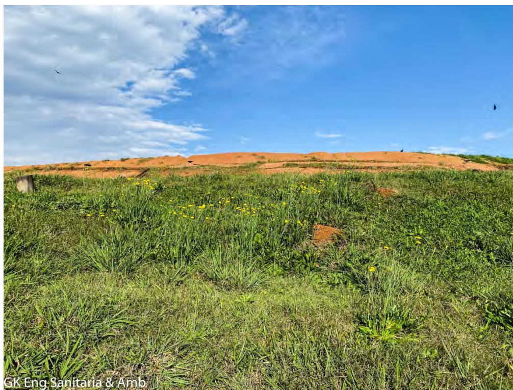
Figura 20 - Vista geral das bermas e taludes da porção nordeste já encerrada do Aterro Sanitário com geometria adequada, indicativa de estabilidade do maciço. Fonte: GK ENGENHARIA, levantamento de campo.
