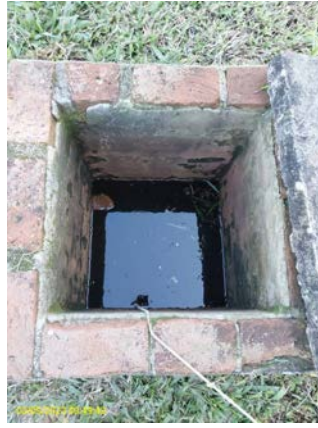
Foto 21 - Caixa de passagem entre as lagoas
