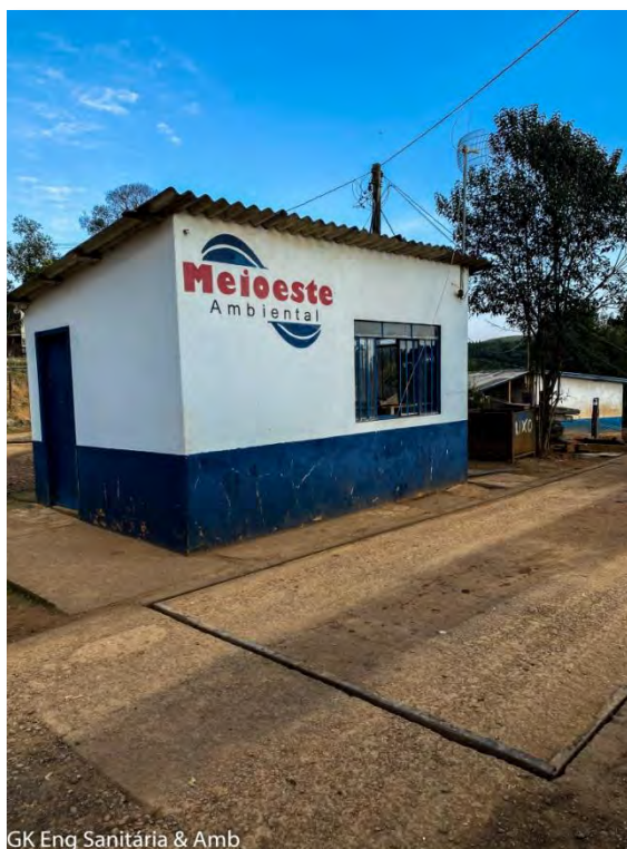
Figura 16 - Edificação onde estão situados os equipamentos de registro da recepção e pesagem das cargas de resíduos que aportam ao aterro sanitário. Fonte: GK ENGENHARIA, levantamento de campo. Destaque para a balança rodoviária de pesagem dos veículos, implantada ao lado.
