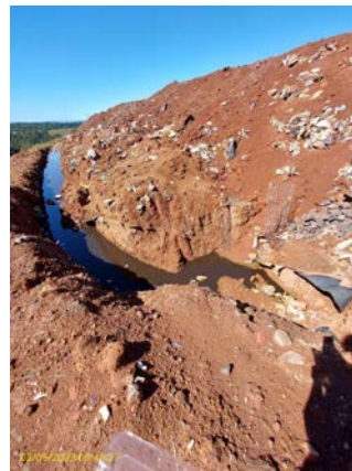
Foto 2 - Acúmulo de líquido na célula em operação
