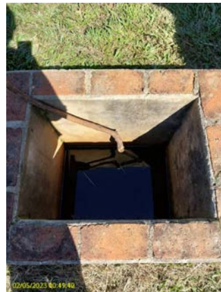
Foto 19 - Caixa de passagem entre as lagoas
