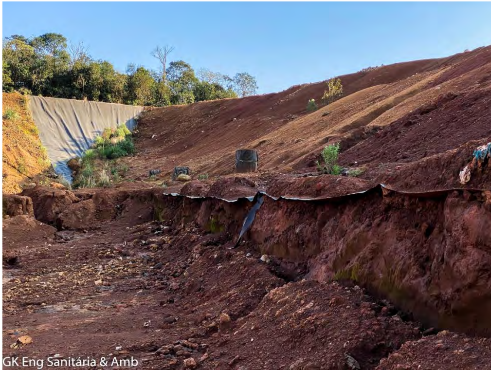
Figura 21 - Perfil com posicionamento da geomembrana de PEAD de 1,5 mm de espessura utilizada na base da célula 1 - ativa. Observar também a camada de argila compactada de 1,00 m de espessura sotoposta à geomembrana. Fonte: GK ENGENHARIA, levantamento de campo.
