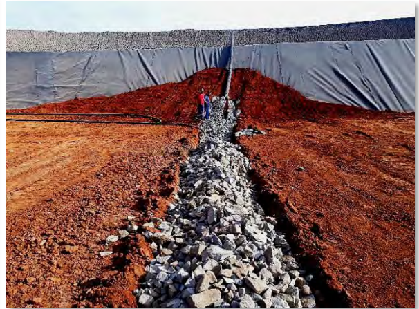
Foto 14 - Após a instalação do tubo de PEAD ocorrerá o preenchimento com pedra rachão da vala de drenagem horizontal.
