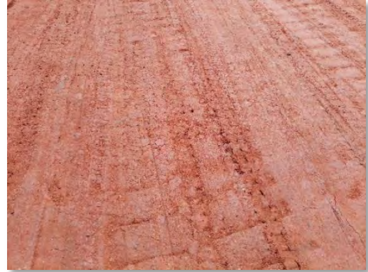
Foto 3 - A selagem e o acabamento final do topo da camada C1 serão realizados com compactação pneumática, a partir de múltiplas passadas de motoniveladora e caminhões basculantes carregados.
