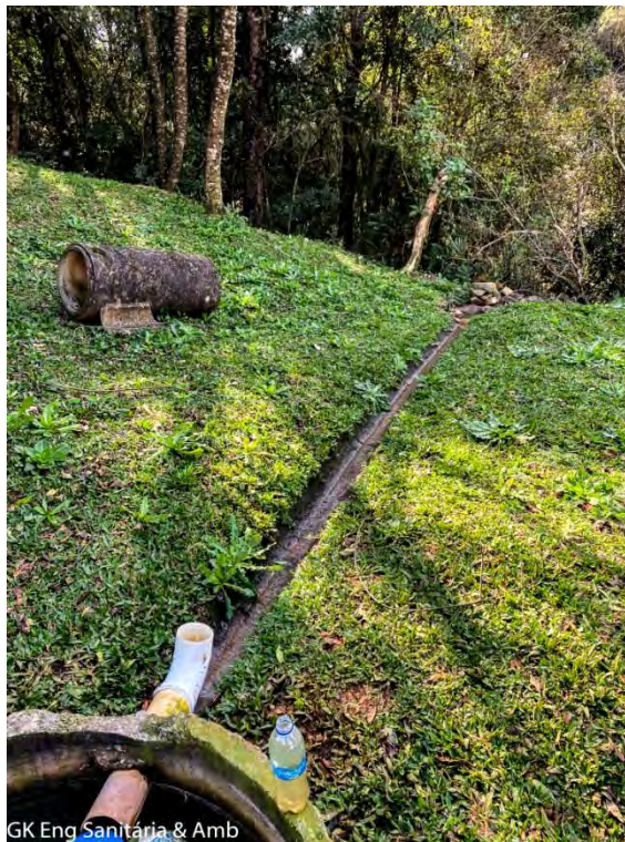
Figura 52 - Canaleta que conduz o efluente tratado desde a ETE até o ponto de emissão. Fonte: GK ENGENHARIA, levantamento de campo.
