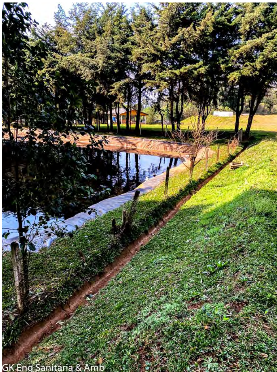
Figura 106 - Drenagem perimetral já implantada na borda da lagoa de tratamento de percolato e cujo padrão construtivo será mantido para implantação nos segmentos faltantes do perímetro de entorno das lagoas. Fonte: GK ENGENHARIA, agosto 2022.
