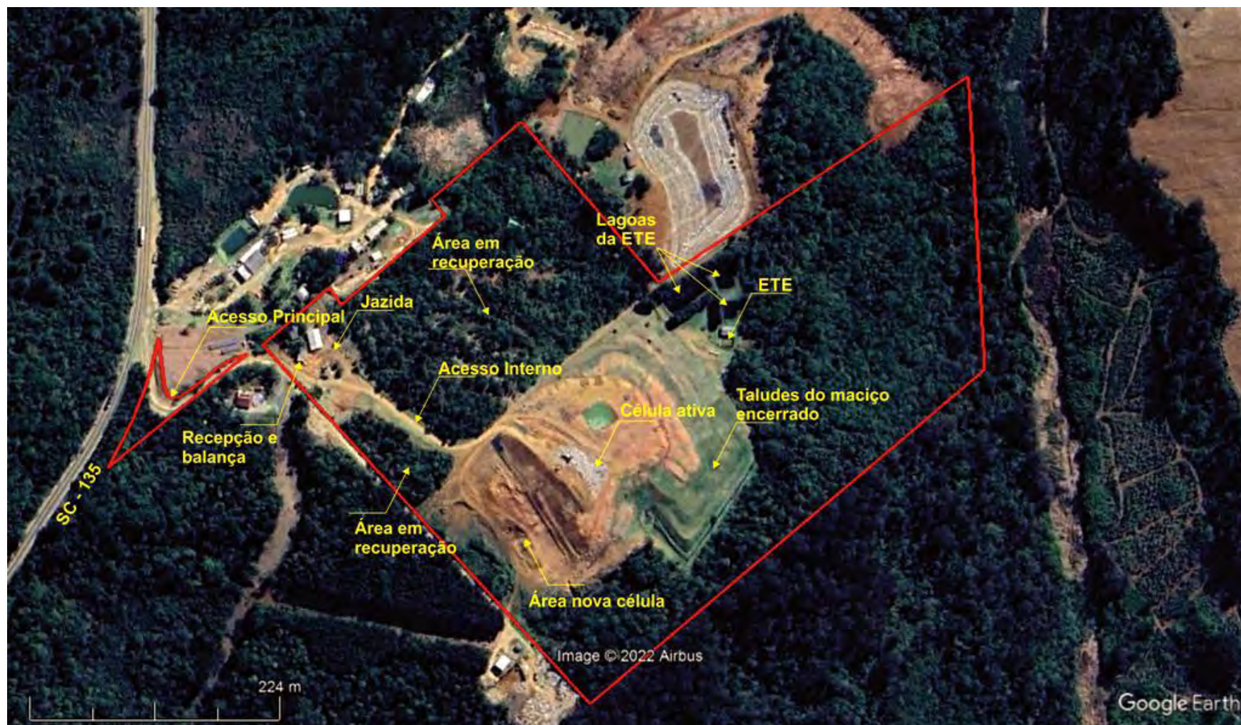
Figura 7 - Layout geral com a distribuição atual no terreno dos principais elementos construtivos do Aterro Sanitário de Caçador - SC. Fonte: GK ENGENHARIA, levantamento de campo sobre imagem disponibilizada no aplicativo Google Earth datada de agosto de 2022. A poligonal em vermelho abrange a área aproximada do levantamento conduzido com drone multirrotor.
