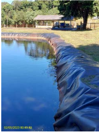
Foto 20 - Impermeabilização das lagoas
