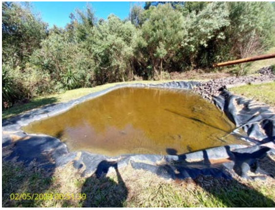
Foto 13 - Lagoa de estabilização
