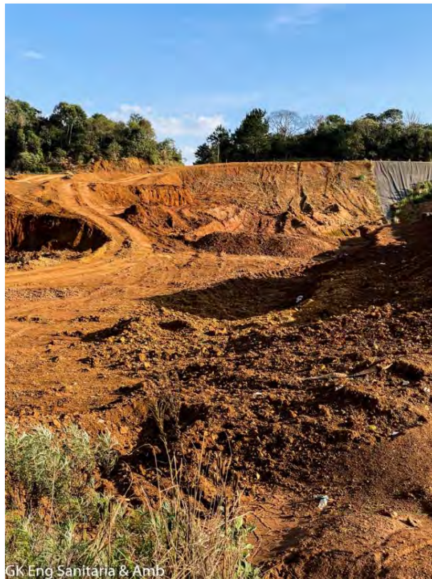
Figura 57 - Vista frontal da área proposta para implantação da nova célula de disposição de resíduos - célula 2. Fonte: GK ENGENHARIA, levantamento de campo.
