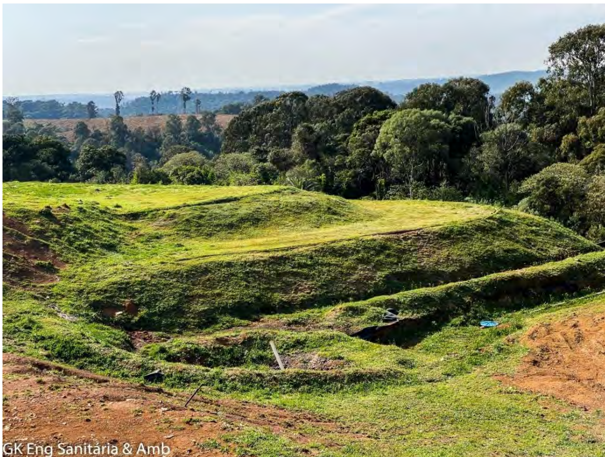
Figura 17 - Vista geral das bermas e taludes da porção já encerrada do Aterro Sanitário com geometria adequada, indicativa de estabilidade do maciço. Fonte: GK ENGENHARIA, levantamento de campo.
