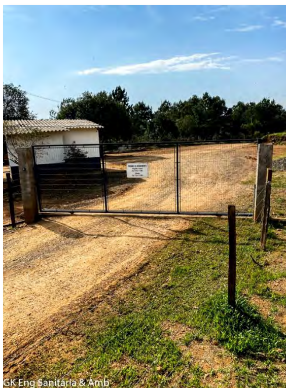
Figura 12 - Portão existente no acesso principal, entrada do Aterro Sanitário. Fonte: GK ENGENHARIA, levantamento de campo.
