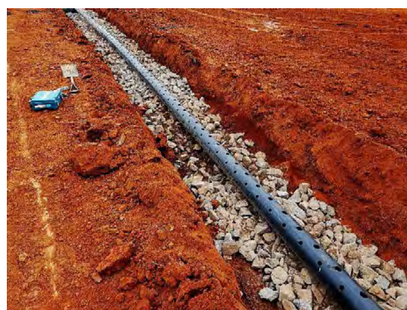
Foto 12 - Instalação do tudo PEAD perfurado sobre a pedra rachão.
