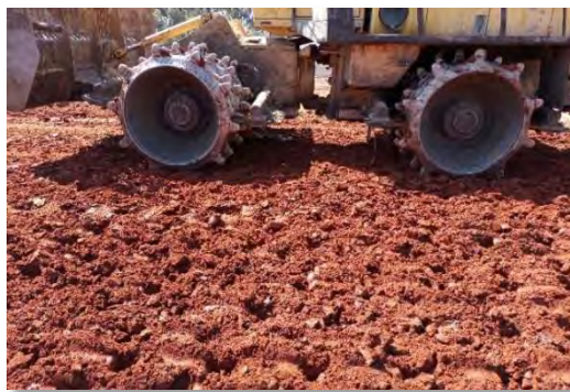
Foto 1 - Procedimento de compactação das camadas de argila.
