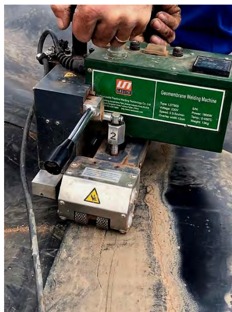
Foto 6 - Detalhe do equipamento de soldagem.
