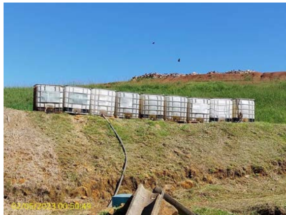
Foto 10 - Tanques de sulfato de alumínio
