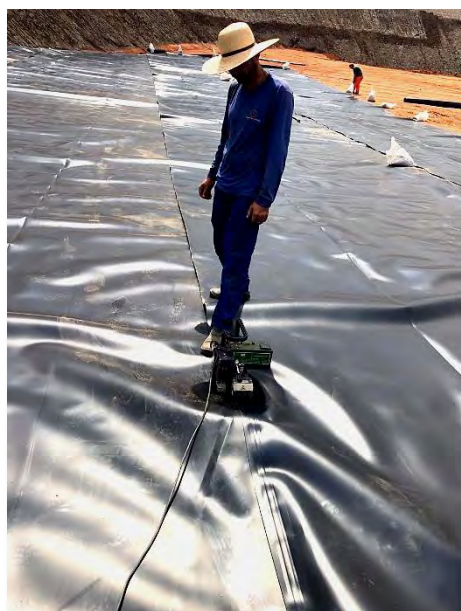
Foto 5 - Exemplo do procedimento de soldagem realizado na geomembrana.
