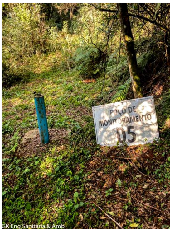
Figura 62 - Poço de monitoramento 05 situado a nordeste na área de interesse. Fonte: GK ENGENHARIA, levantamento de campo.
