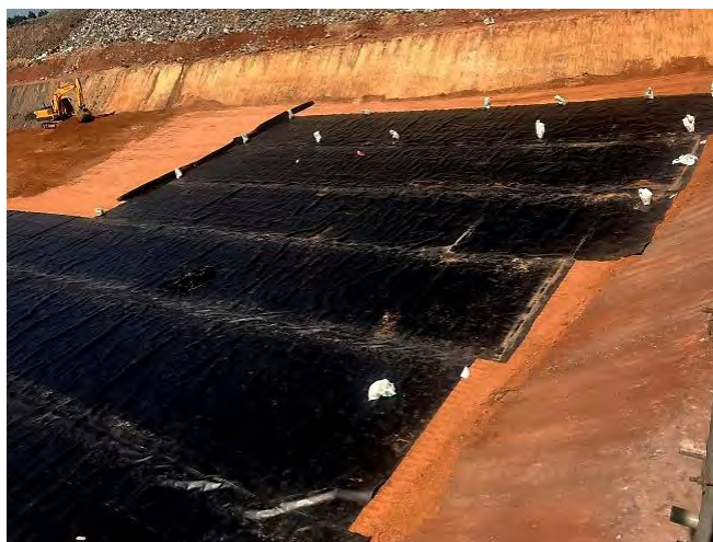
Foto 4 - Exemplo construtivo da instalação da geomembrana de PEAD sobre a camada de argila compactada C1.
