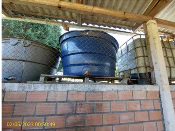
Foto 7 - Tinas de coleta de água da chuva
