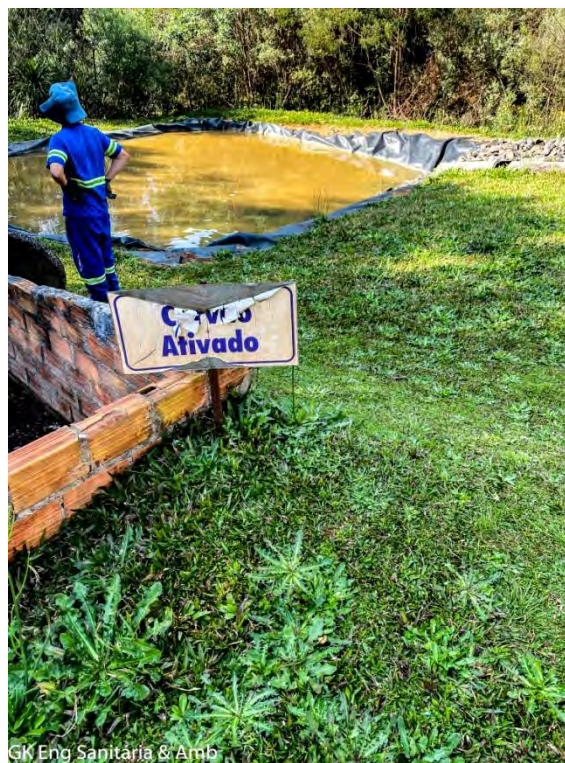
Figura 50 - Vista lateral do módulo de tratamento com carvão ativado. Fonte: GK ENGENHARIA, levantamento de campo.
