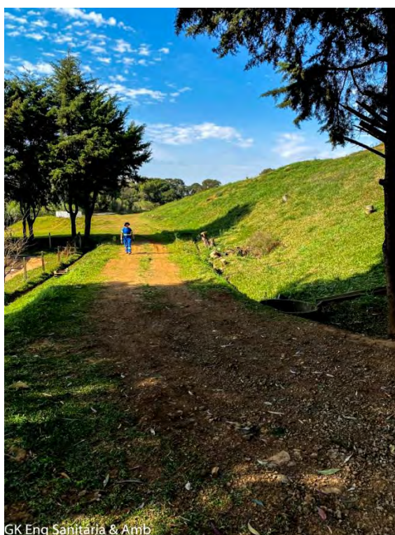
Figura 19 - Vista lateral do talude sudoeste com geometria adequada e sem feições de instabilidade. Fonte: GK ENGENHARIA, levantamento de campo.
