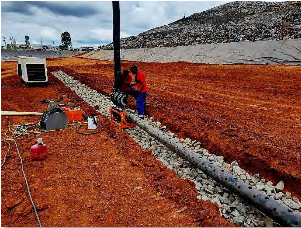
Foto 13 - Soldagem dos segmentos de tudo PEAD e espera para os drenos verticais de drenagem de chorume e gás.
