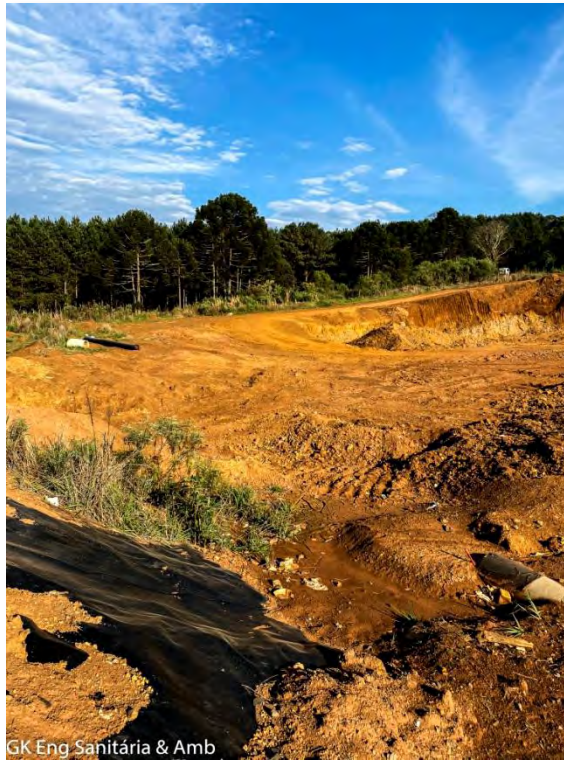
Figura 56 - Outra vista da área proposta para implantação da nova célula de disposição de resíduos - célula 2. Fonte: GK ENGENHARIA, levantamento de campo.
