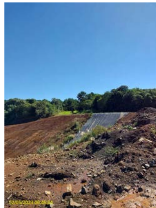
Foto 2 - Geomembranda sendo colocada na nova célula de operação
