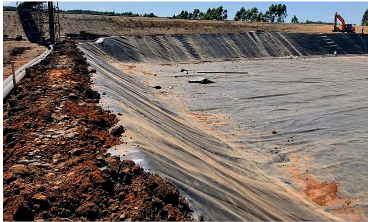
Foto 8 - Exemplo construtivo de reaterro da vala perimetral após a instalação e ancoragem da geomembrana no topo do talude.
