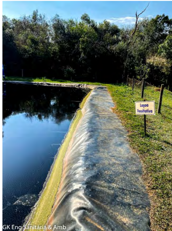
Figura 39 - Detalhe da lagoa facultativa. Fonte: GK ENGENHARIA, levantamento de campo.
