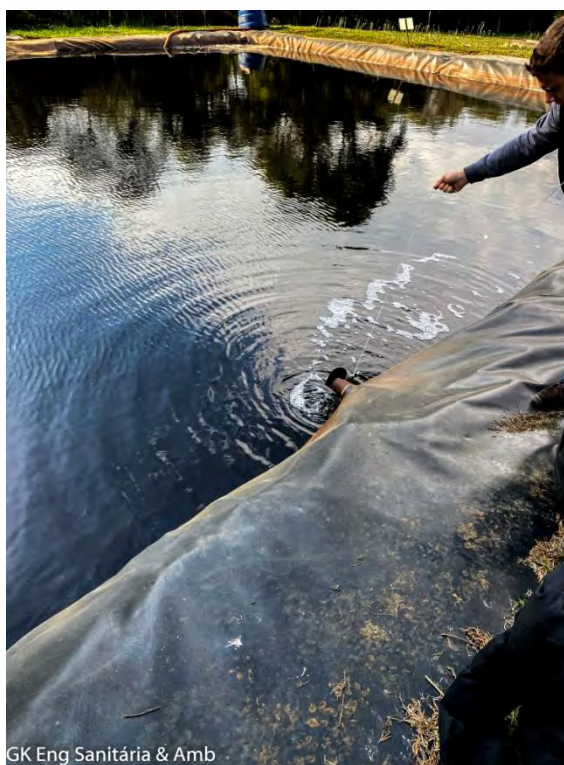
Figura 37 - Ponto de entrada do efluente captado no maciço na primeira lagoa do sistema de tratamento (anaeróbia). Fonte: GK ENGENHARIA, levantamento de campo.
