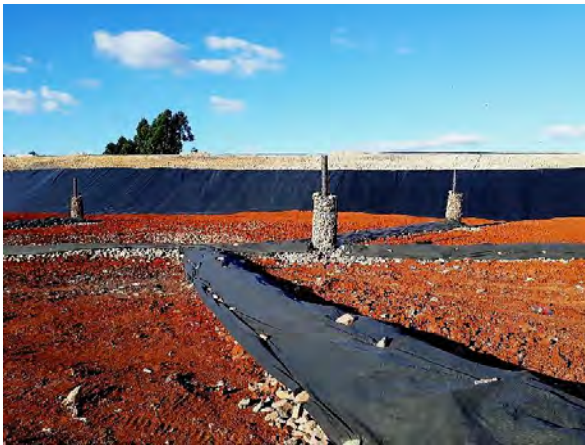
Foto 15 - Recobrimento da vala dos drenos com manta geotêxtil Bidim.
