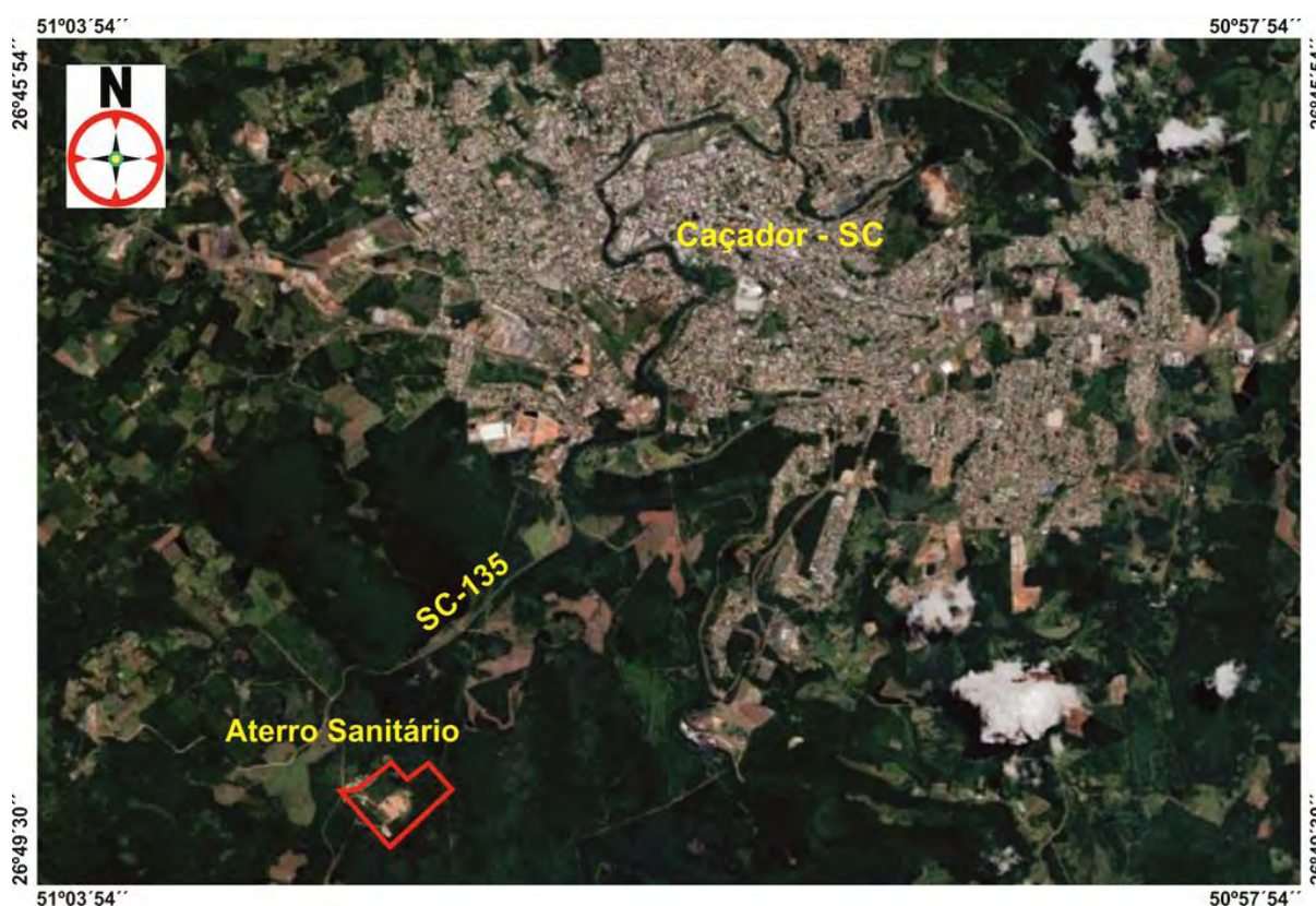
Figura 1 - Situação e localização do Aterro Sanitário Municipal de Caçador - SC. Fonte: GK ENGENHARIA sobre imagem do aplicativo Google Earth.
