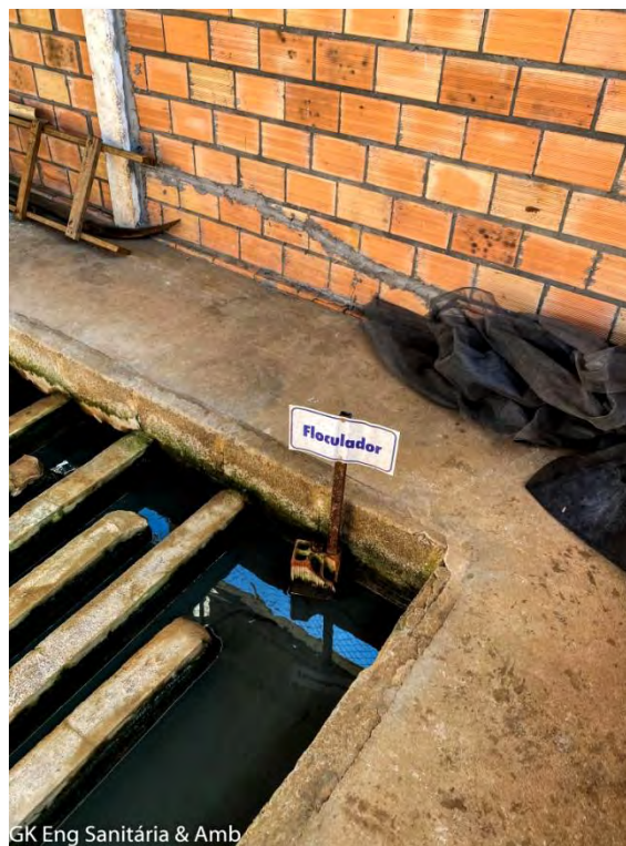
Figura 46 - Vista de detalhe do módulo floculador da ETE. Fonte: GK ENGENHARIA, levantamento de campo.
