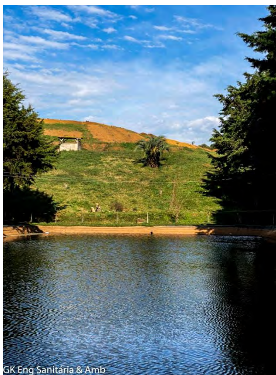
Figura 18 - Vista principal a sudoeste das bermas e taludes da porção já encerrada do Aterro Sanitário com geometria adequada, indicativa de estabilidade do maciço. Fonte: GK ENGENHARIA, levantamento de campo.
