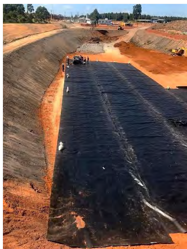
Foto 4 - Exemplo construtivo da instalação da geomembrana de PEAD sobre a camada de argila compactada C1.
