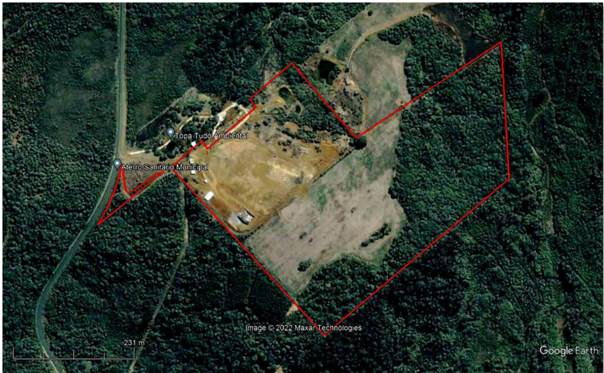
Figura 2 - Imagem de satélite da área do Aterro Sanitário Municipal no ano de 2003, na fase inicial de operação. Fonte: Imagem disponível do aplicativo Google Earth datada de 27/08/2003.
