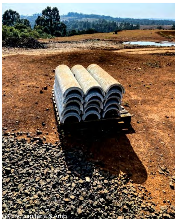
Figura 102 - Padrão das estruturas de drenagem pluvial do tipo meia cana de concreto atualmente utilizadas no aterro sanitário e que permanecerão na implantação da célula 2.
