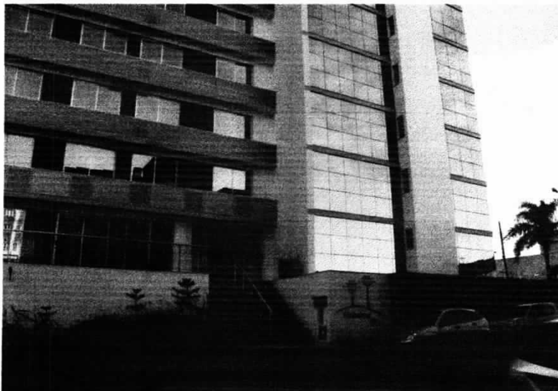
Vista da via pública e fachada.
