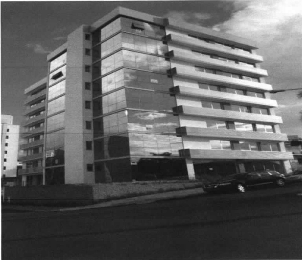
Vista da via pública e fachada.
