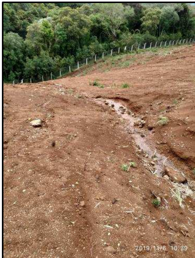
Alambrado do lado direito da RNY 02/20 – Em ótimas condições.
