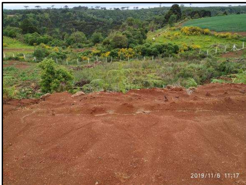
Alambrado do lado direito da RNY 02/20 – Em ótimas condições.
