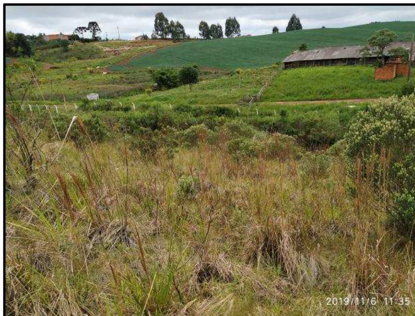
Alambrado próximo a THR 20 – Em ótimas condições.
