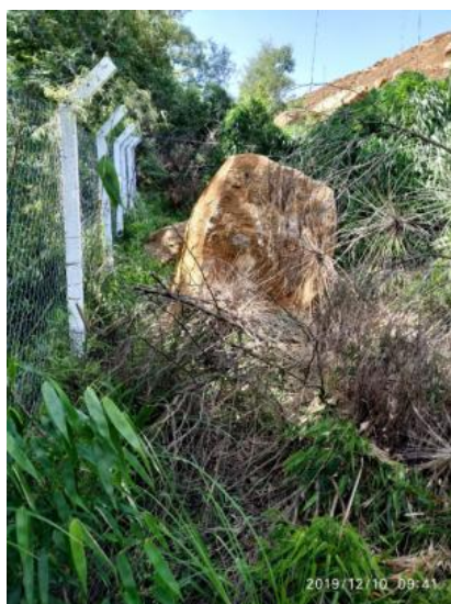
Figura 6.2 - Detalhe de matacão rolado da saia do aterro da PPD
