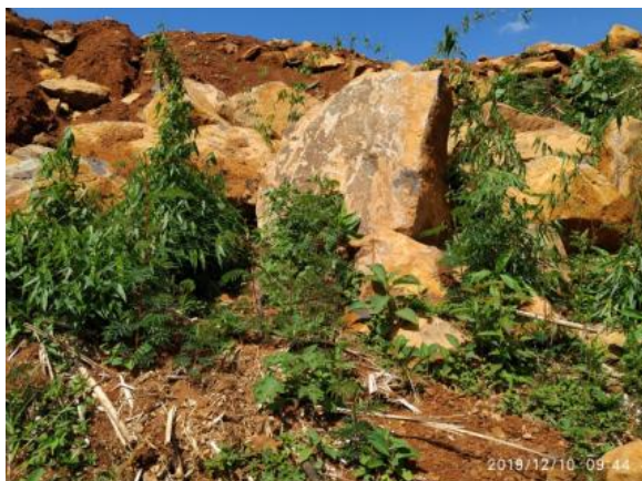
Figura 6.4 - Vista geral do aterro de solo-enrocamento da faixa de pista da PPD
