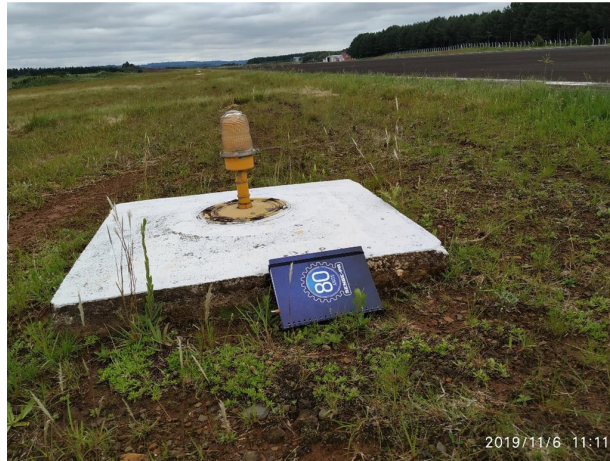
Figura 0-2 – Nivelar as bases de concreto do balizamento noturno.
