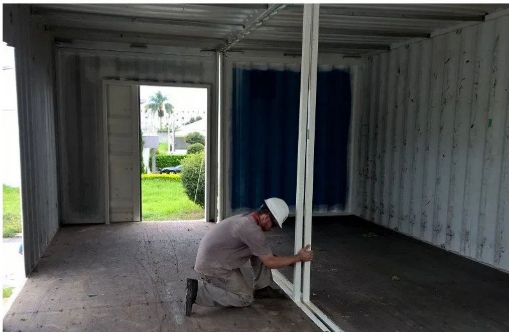
Figura 3: unificação de contêiner com a retirada da parede lateral
