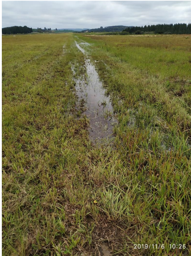
Figura 0-4 – Empoçamento de água na lateral da pista, favorece a saturação do maciço e a instabilidade do talude.
